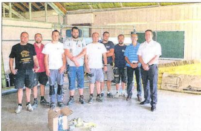
Les élus et les entreprises présentes sur le chantier. Photo Le D.U.R.M.C.
